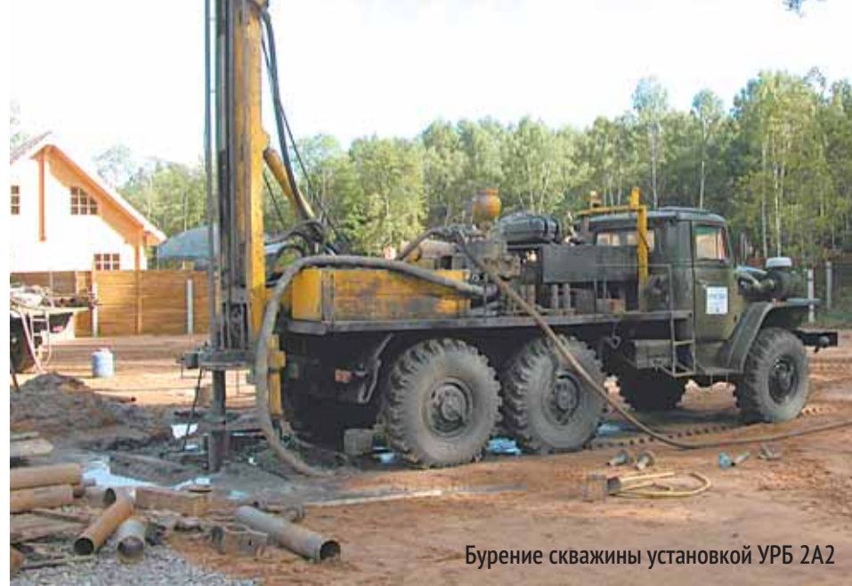
Рабочая площадка при бурении установкой УРБ 2А2
